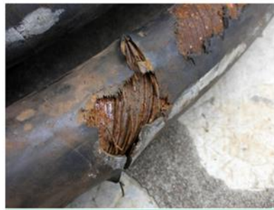
Ruptura da mangueira devido a desgaste da cobertura
